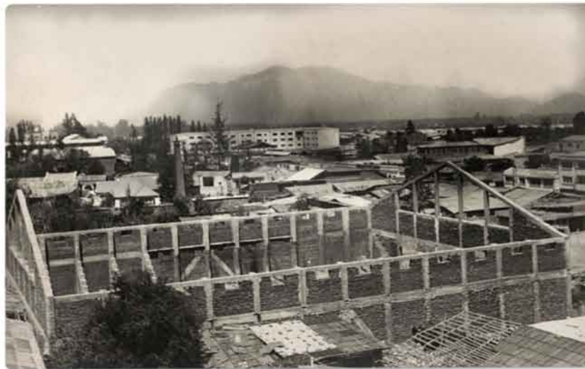
Construcción Gimnasio Municipal (1957)
