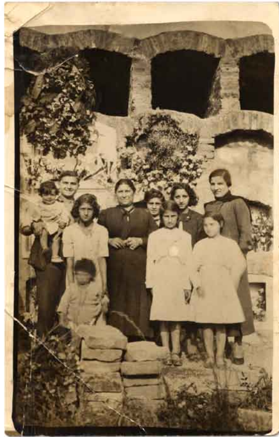
Cementerio Bajos de Mena (c.1930)
